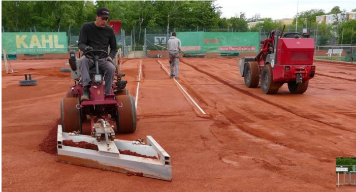
Abfräsen der Oberfläche
