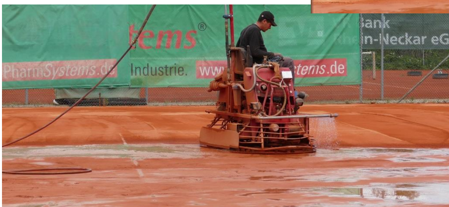
Einschlämmen des Sandes
