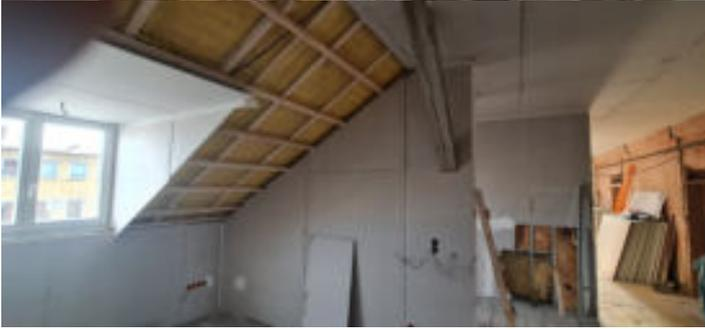
Dann wird einseitig beplankt, als Vorbereitung für die Rohinstallation der Gewerke Sanitär sowie Elektro für Strom und Medien.
