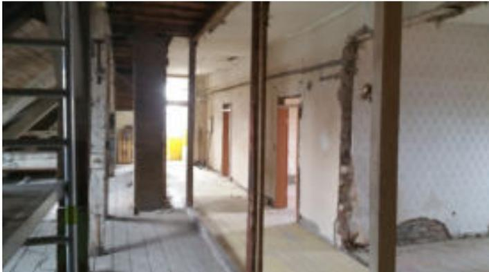
Jetzt kommt die statische Ertüchtigung, da durch die verschiedenen Entnahmen von Mauern und Wänden Bauteile Lasten bekommen haben, für die sie nicht ausgelegt waren und die sie nur aus Gutmütigkeit mitübernommen haben.
