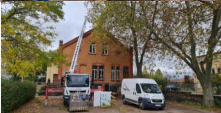
Die Öffnungen im Dach werden auch gleich für den Transport der Trockenbaumaterialien genutzt, damit man nicht tonnenweise Material durch das Treppenhaus schleppen muss.
