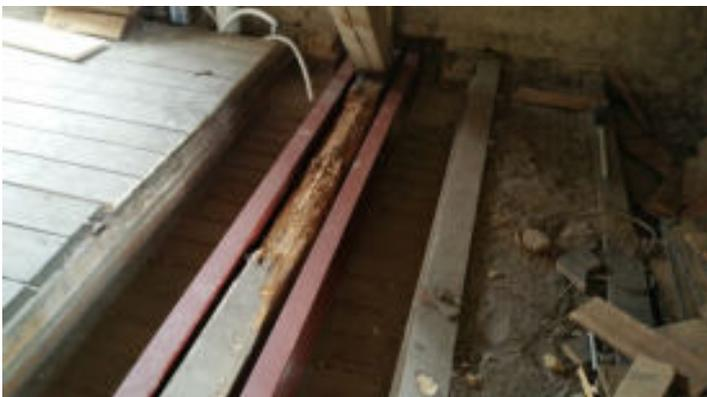
Und die Holzpfeiler wurden durch eine Stahlkonstruktion ersetzt, die aussteift, Dachlasten aufnimmt und sie an geeigneter Stelle an darunter liegende Mauern weitergeben kann.
